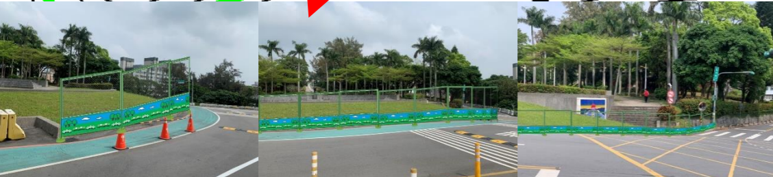
管制口(一) Access Control No.1
